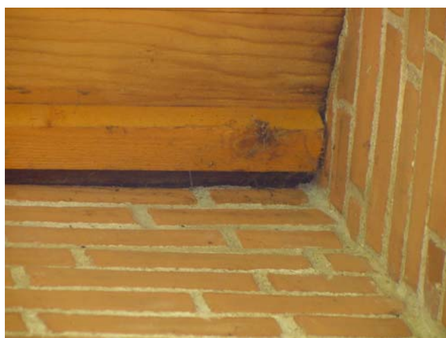
Figur 1.2 Ventilationsspalte ved tagfod
