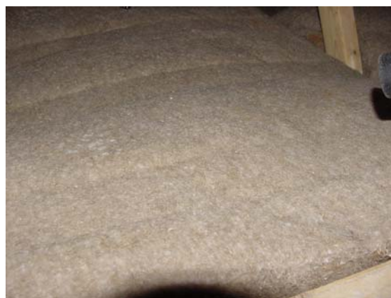
Figur 6.5.3 Skimmelvækst i overflade af hørmåtter
