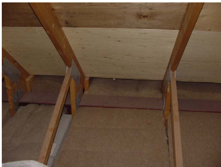
Figur 3.2 Hørisolering på loft. (Ingen isolering over skilleveg eller stålbjælke).
