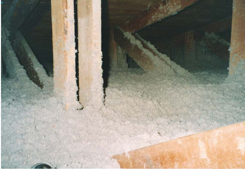
Figur 3.1 Papirisolering på loft
