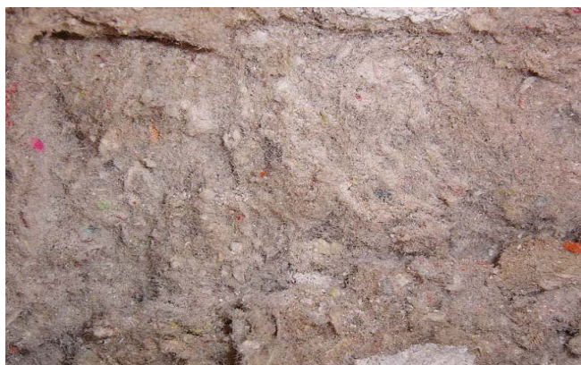
Figur 5.2 Papirisolering i hulmur
