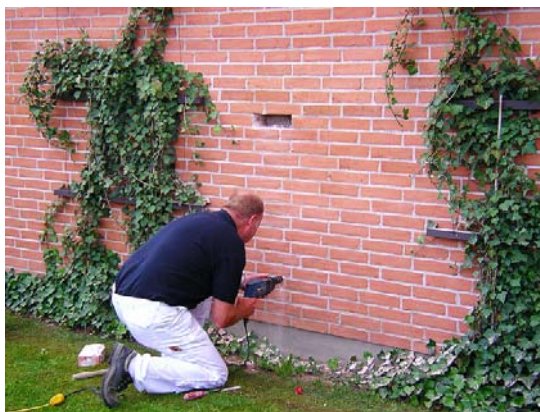
Figur 5.1 Udhugning i gavl mod nord
