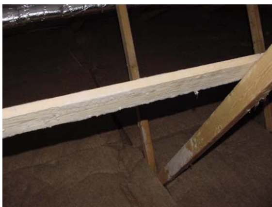
Figur 6.5.2 Skimmelvækst på gitterspær
