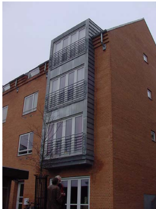
Figur 1.2 Karnap mod syd. Fugtskjold fornedet ved karnap-sidevæg
