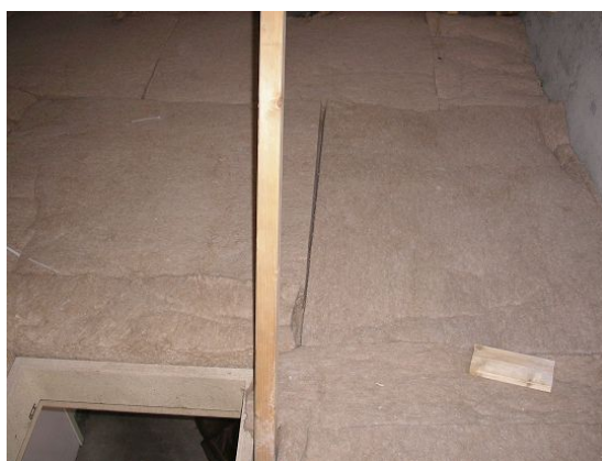
Figur 5.2.3 Hørmåtter på loft
