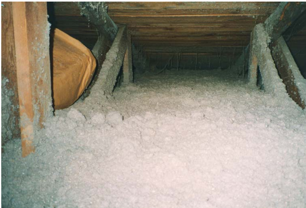
Figur 3.2 Papirisolering på loft
