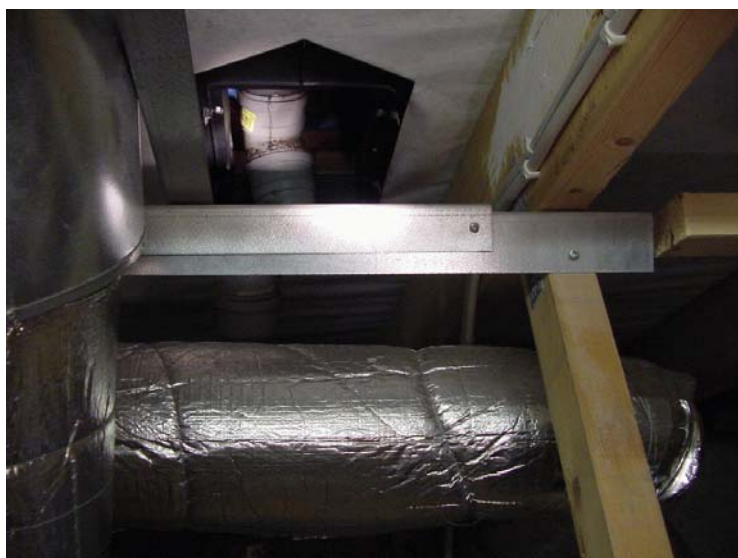
Figur 1.2 Kompliceret rørgennemføring (bemærk dagslysplet)
