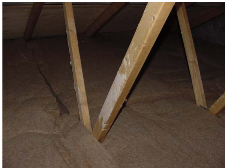
Figur 1.2 Skimmelvækst på spær (fuger mellem hørmåtter)
