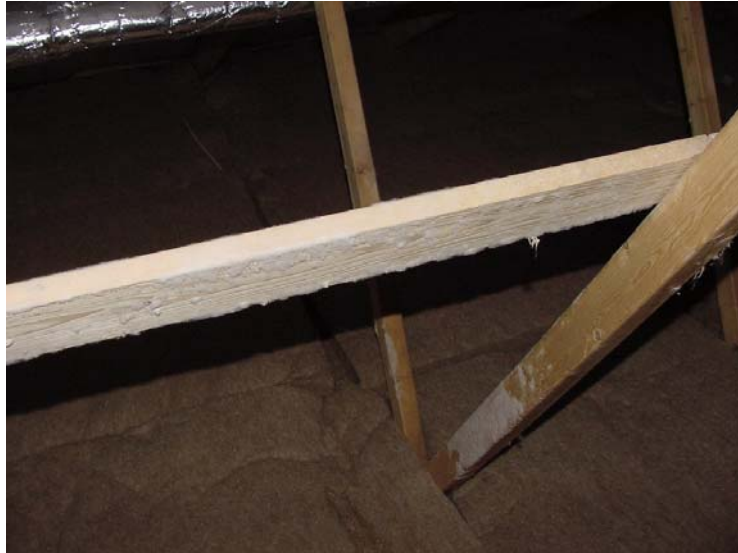
Figur 2.1 Skimmelvækst på spær
