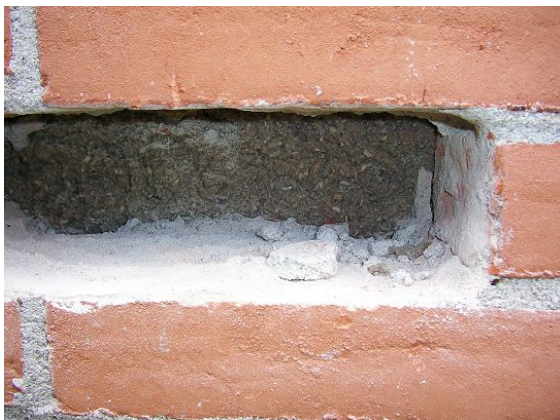
Figur 6.4.1 Papirisolering i hulrum
