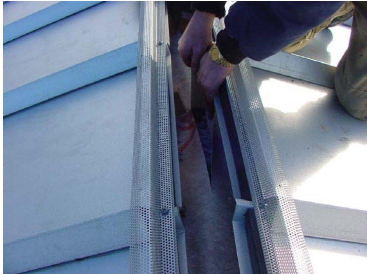
Figur 3.2 Modhold af diffusionsåbent undertag og ekstra afstandslægter. God fyldning ved kip (ingen "lommer")
