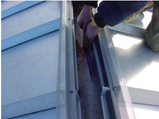
Figur 6.6.8 Paralleltag udført med modhold af undertag og skrålægter
