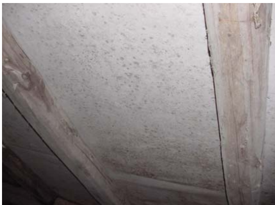
Figur 6.5.4 Skimmelsvamp efter kondensering på diffusionsåbent undertag
