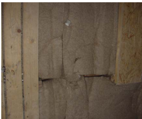
Figur 6.2.1 Hørmåtter på loft
