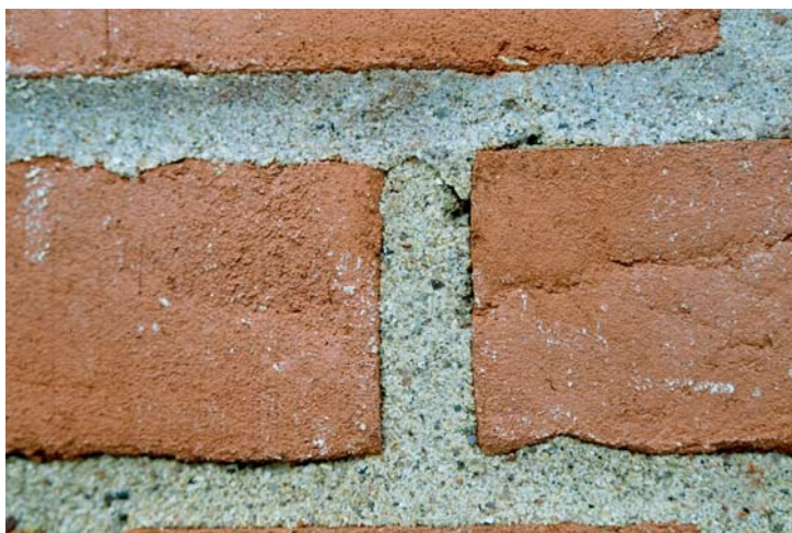
Figur 1.2 Nærbillede af mørtelfuge i sydgavl
