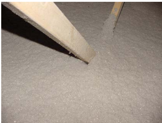
Figur 1.2 Isolering på loft
