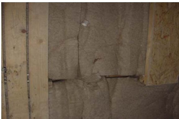
Figur 6.2.1 Hørmåtter på loft
