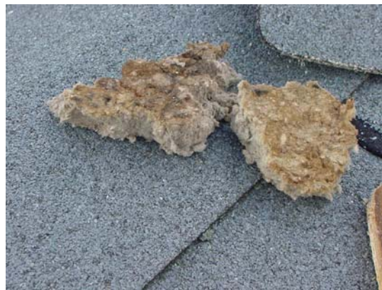
Figur 3.2 Papirisolering fra Hul 1
