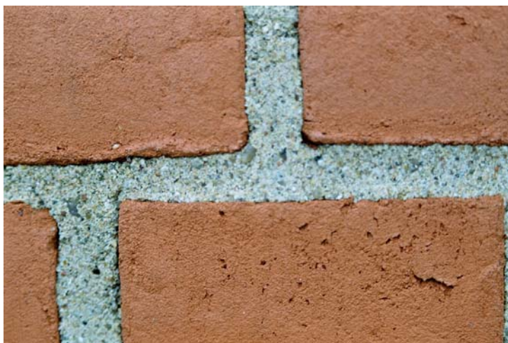
Figur 1.3 Nærbillede af mørtelfuge i sydgavl
