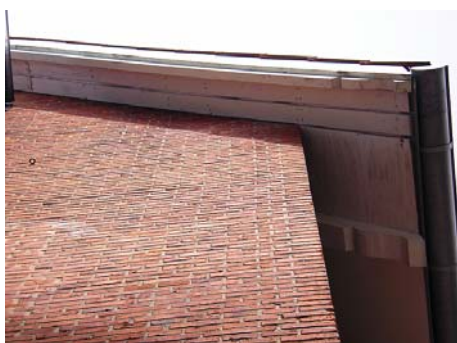
Figur 2.2 Undertag oven for ventilations- spalter ved gavle
