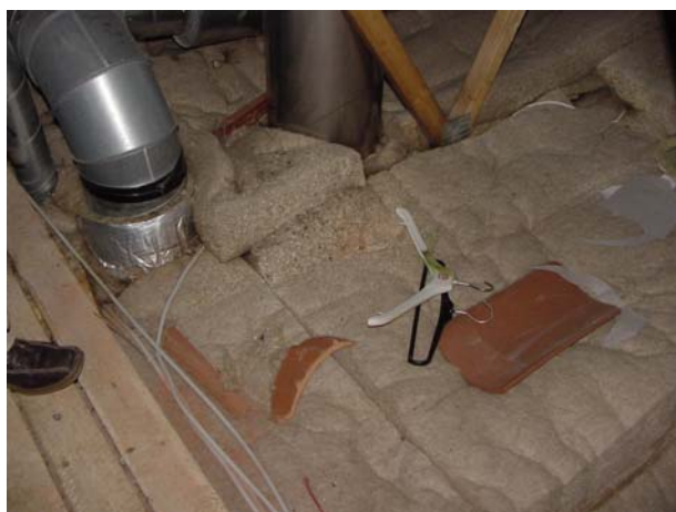
Figur 1.3 Skimmelvækst i hør, ved afkast fra bageri til tagrum!
