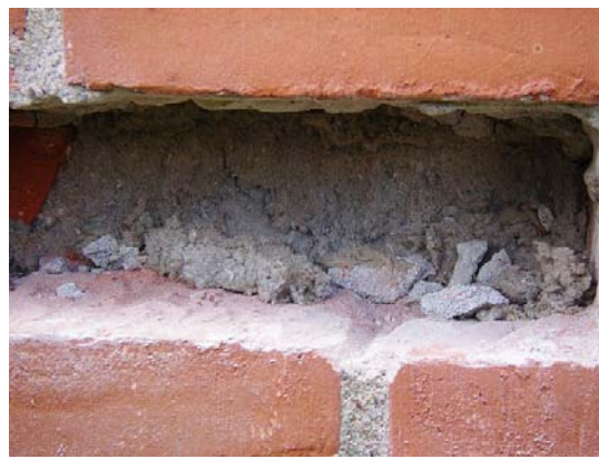
Figur 5.2 Papirisolering i hulmur
