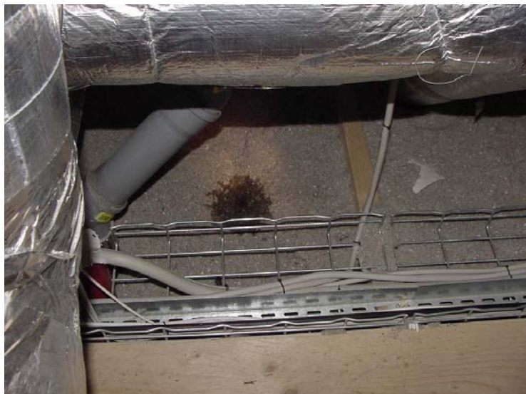
Figur 1.1 Papirisolering i loftrum. Dryp fra rørgennemføring (ser herunder)
