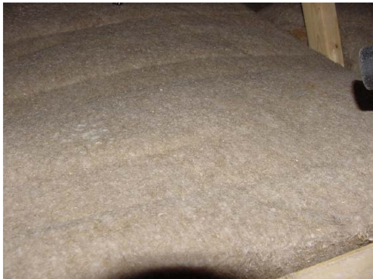
Figur 2.2 Skimmelvækst i hørisolering (i et område)
