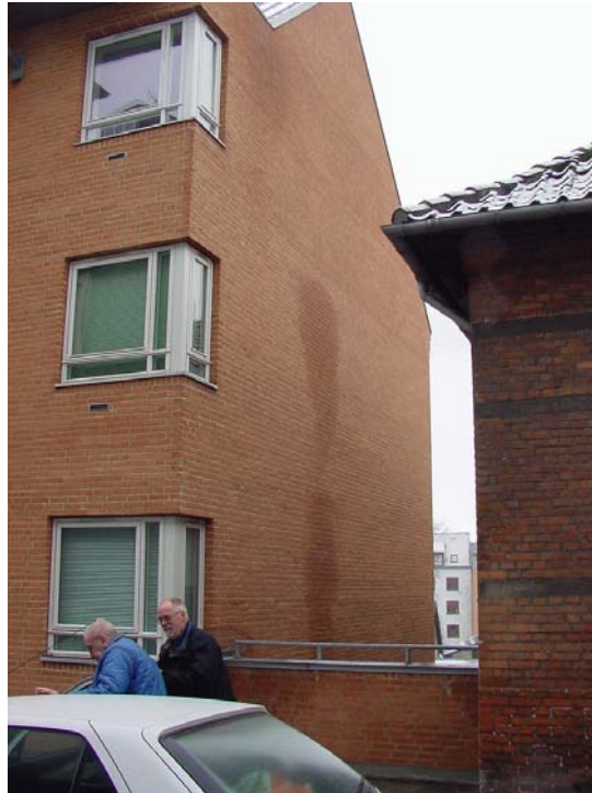
Figur 1.1 Gavlv mod vest. Fugtskjolder midt på væg, ved tagkant og ved/på uisoleret murafrænsning ved terræn
