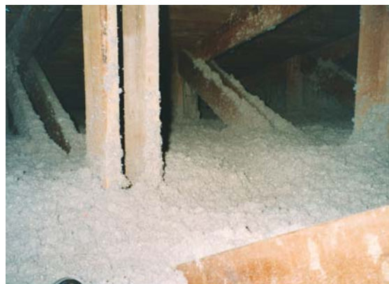
Figur 6.3.2 Papirisolering på loft
