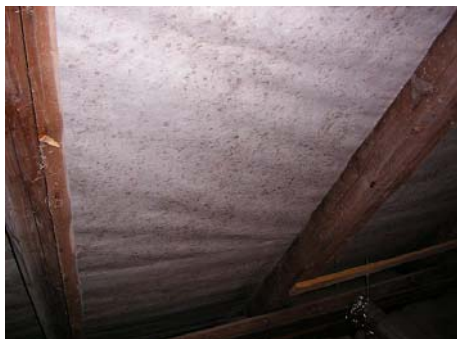
Figur 2.1 Skimmelvækst på undertag. Bemærk ingen skimmelvækst på ældre spærtag
