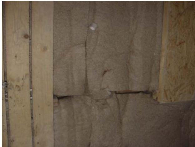
Figur 1.1 Fuge mellem hørmåtter
