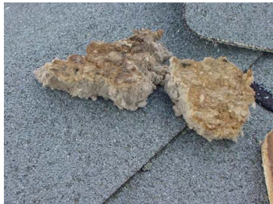
Figur 6.5.6 Skadet papirisolering fra paralleltag
