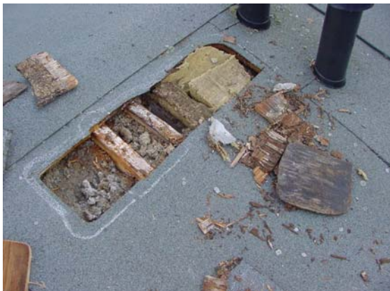
Figur 6.5.5 Paralleltag, fugtskaded ved kip
