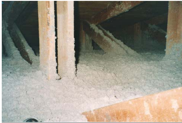
Figur 5.1.1 Løsfyldsisolering på loft
