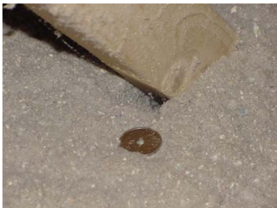
Figur 6.3.1 Sætning i papirisolering (5-krone)
