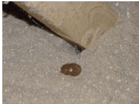
Figur 1.3 Isolering på loft, nærfoto (5-krone)
