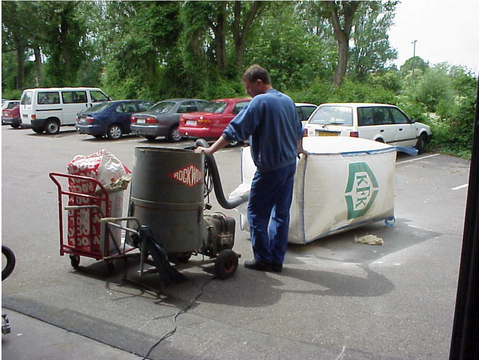
Foto 3.5.1. Udblæsning af løsfyldsisolering. Materialet blæses ind i 3m 3 fodersæk. Indblæsningsmaskinen er lånt til formålet.
