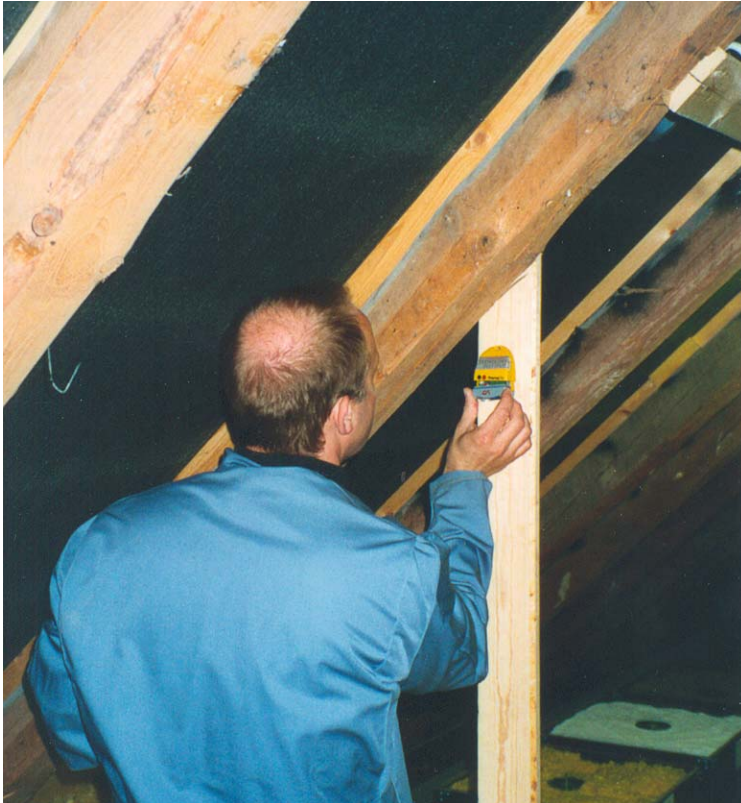
Foto 3.9.1. Højbjergparken 1. Minidatalogger under montage i loftrum.
