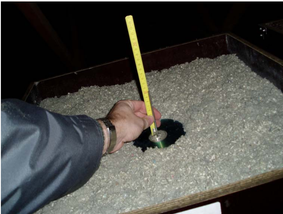
Foto nr. 3.6.1. Sætningsmåling i kasse nr. 1, Ekofiber. Kassen er installeret på Karensvej 7 uden vibrationsdæmpning.
