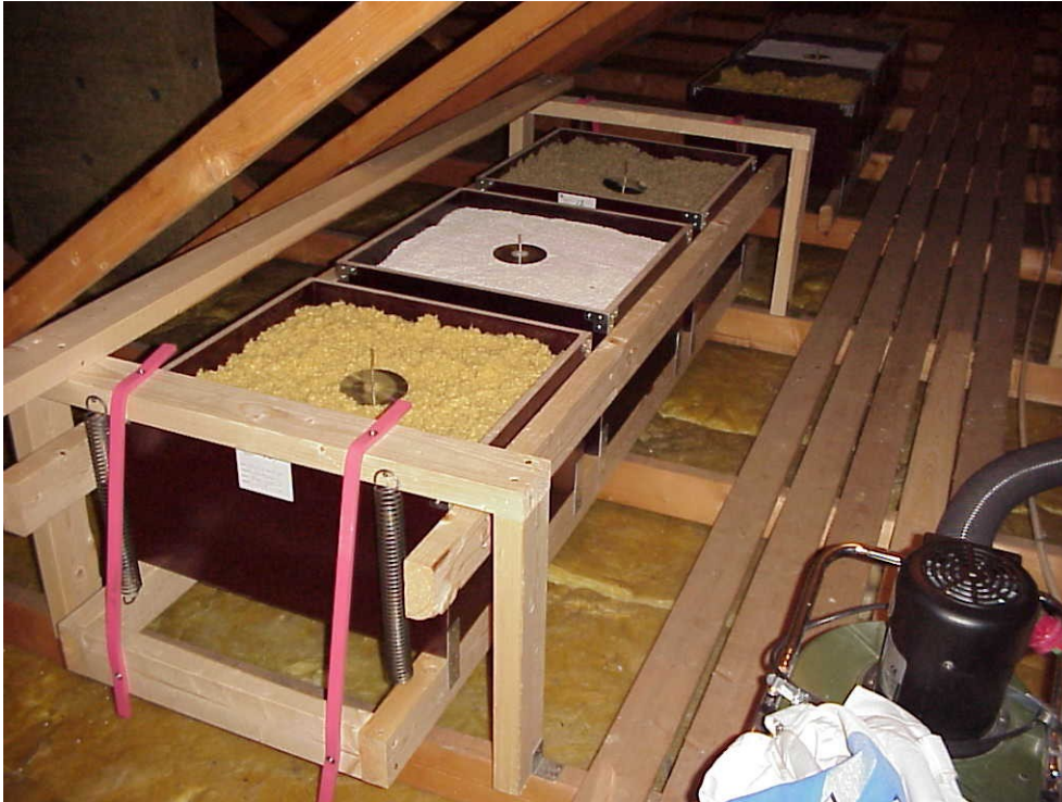
Foto 3.4.2. Karensvej 7, kasse nr. 10, 11 og 12. Vibrationsisolerede kasser. Kasserne står på en ramme af halvtømmer, der er ophængt i fjedre. Ved hver fjeder er monteret et diepolastbånd som svingningsdæmper.
