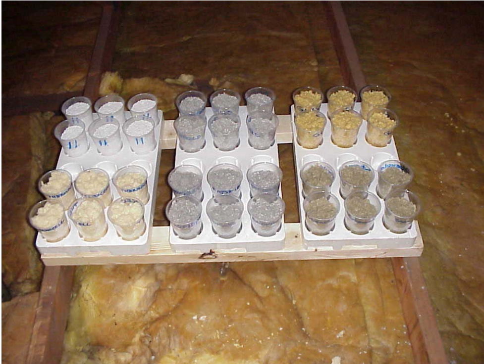
Foto. 3.8.1. Karensvej 7. Bægre med løsfyldsmateriale til bestemmelse af fugtindhold i forbindelse med sætningsmålinger.
