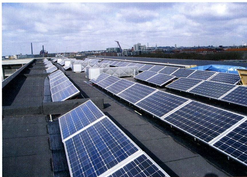
Der var plads til ca. 200 m 2 solcellepaneler på det flade tag, og dermed kunne arbejdet gennemføres uden indgreb i byggeriet eller større forstyrrelser.
