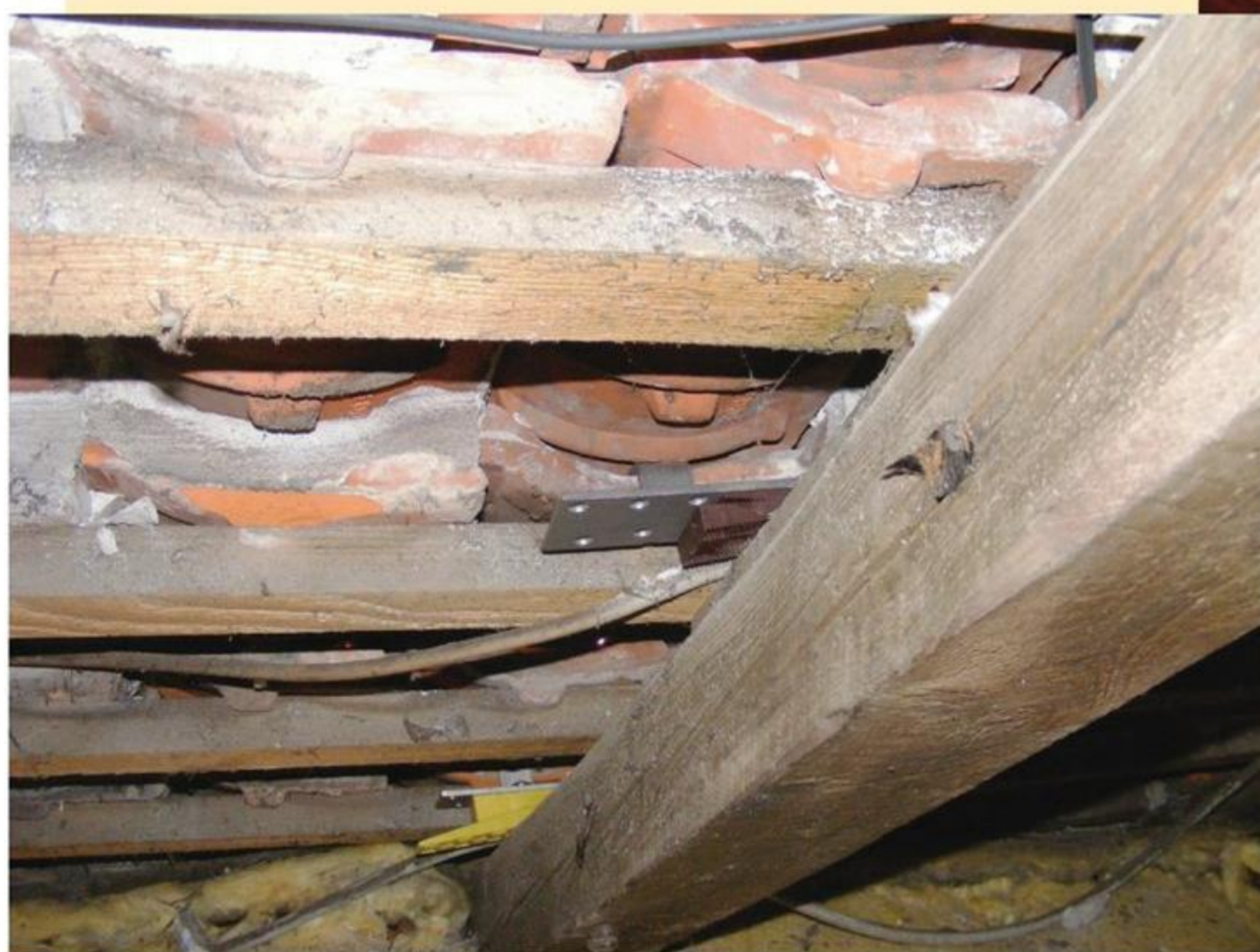
Fig. 19. Understrygning krakleret.
