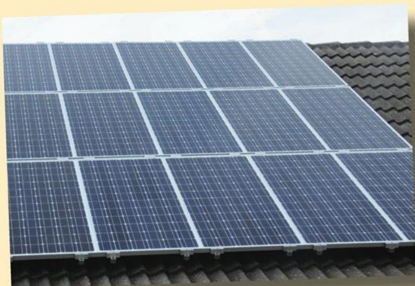
Fig. 17. For lille afstand mellem solcellepaneler.
