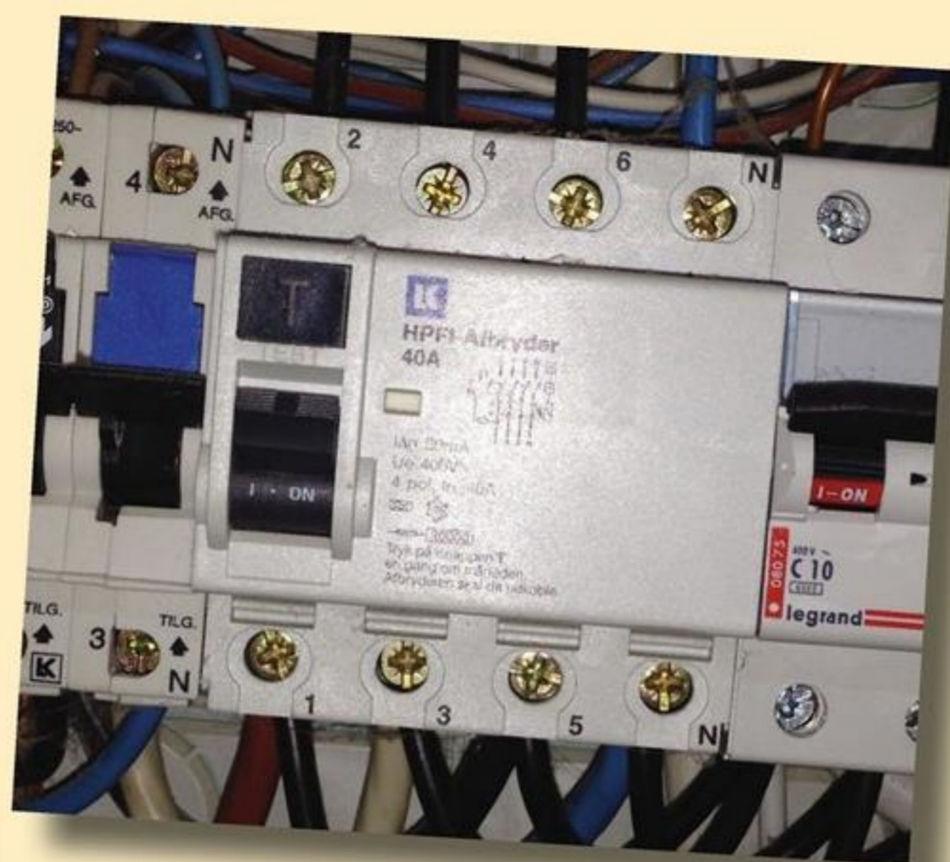
Fig. 23. Forkert type fejlstrømsafbryder.
