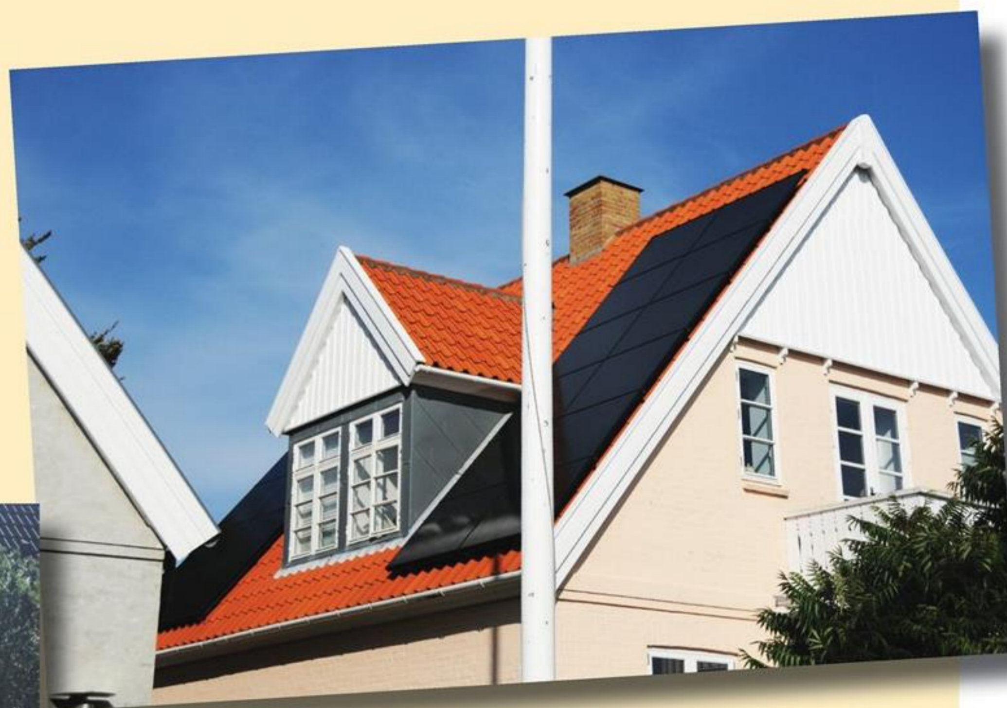
Fig. 15. Skygger fra flagstang, kvist og nabohus.
