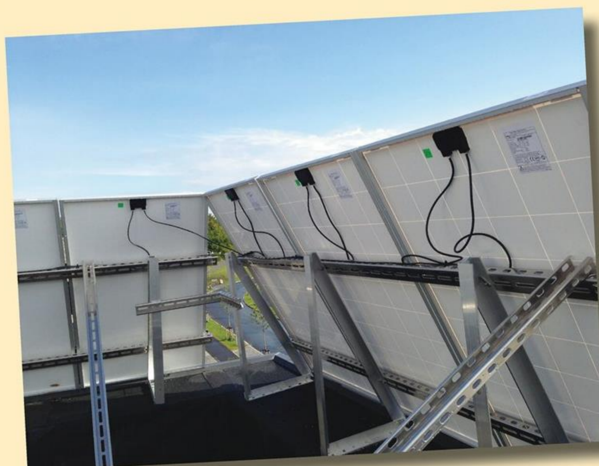
Fig. 11. Forskellig orientering af solceller i samme streng.
