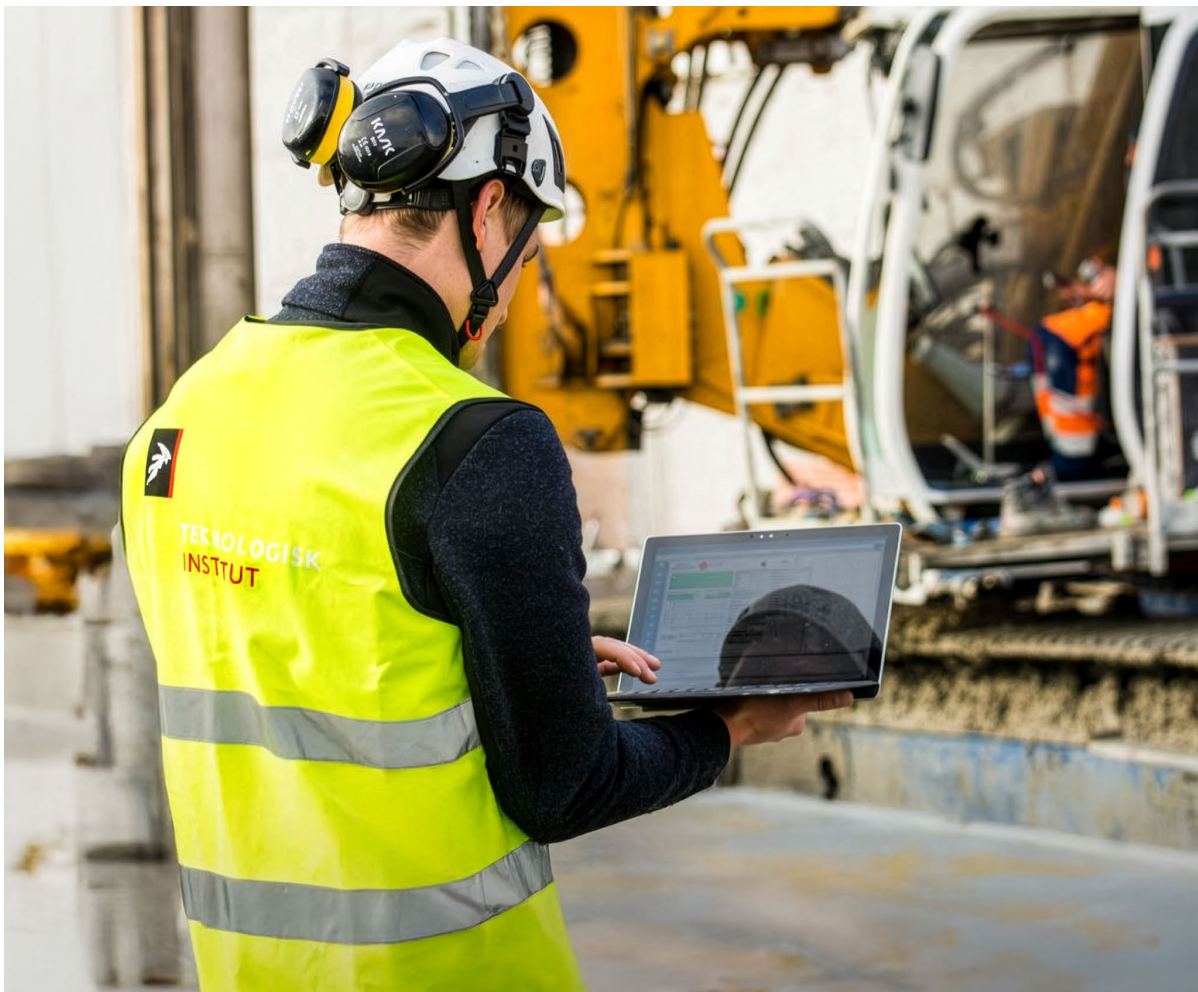
'Fremtidens grønne byggeplads' undersøger, hvordan nye teknologier og arbejdsmetoder kan reducere byggepladsens klimaaftryk. © Teknologisk Institut.
